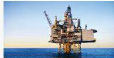
Traitement du gaz et des fluides
