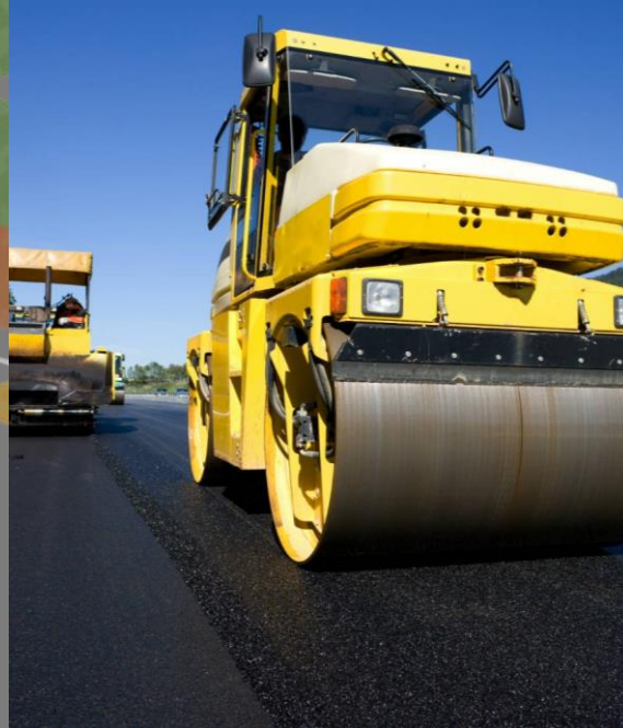
TP et Construction
