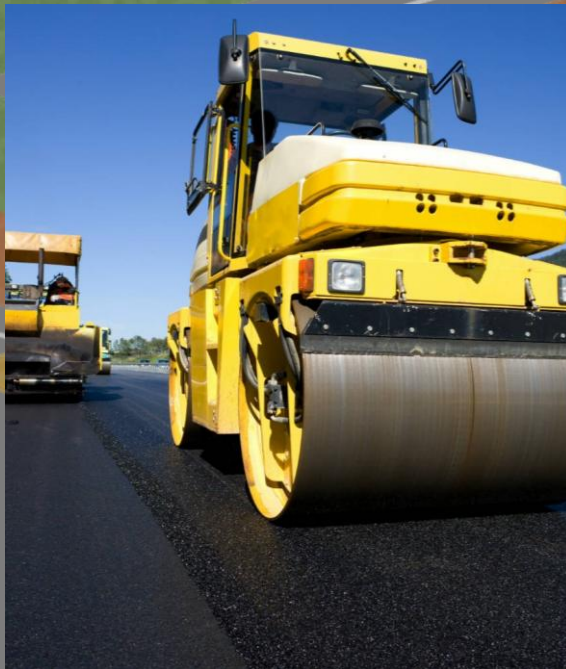
TP et Construction
